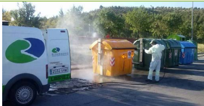
Limpieza de contenedores y recintos con agua caliente a presión
