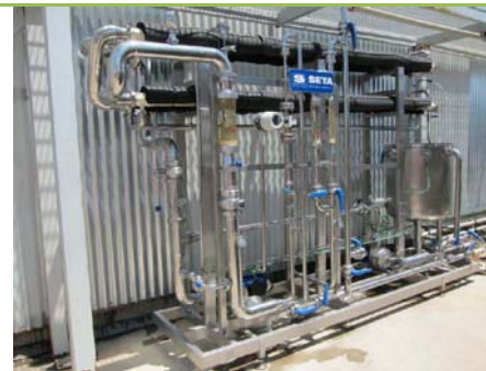
EDAR : CAF (izquierda) y Ultrafiltración (derecha)
