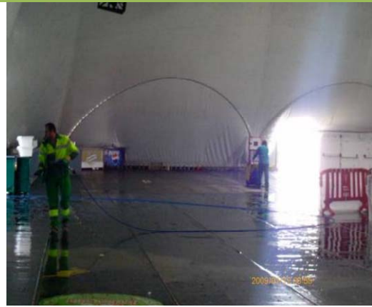
Limpieza con agua a presión
