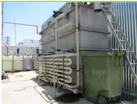
EDAR : CAF (izquierda) y Ultrafiltración (derecha)
