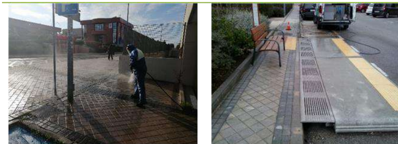
Limpieza de pavimentos
