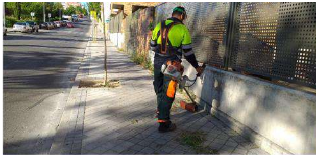
Desbroce de acera y bordillos
