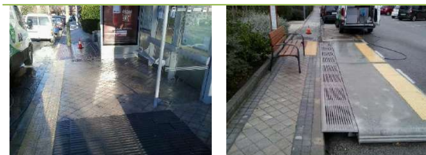
Limpieza de pavimentos
